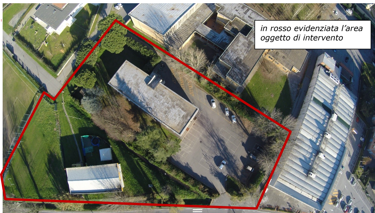
Foto 1- Vista generale area d'intervento
